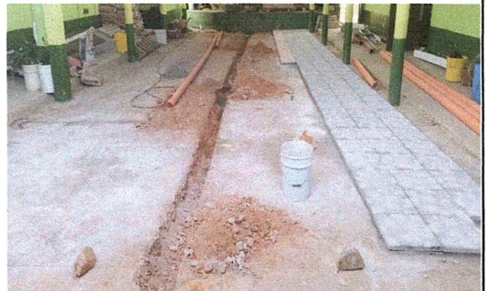
Foto 4: Instalacion de piso martilado en galera del establecimiento
