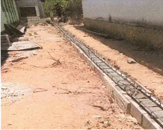
Foto1: Instalacion de malla en el perimetro del establecimiento
