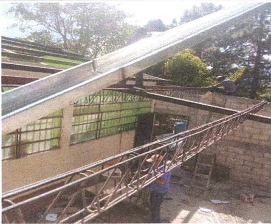
Foto 3: Cambio de entechado en 4 modulos
